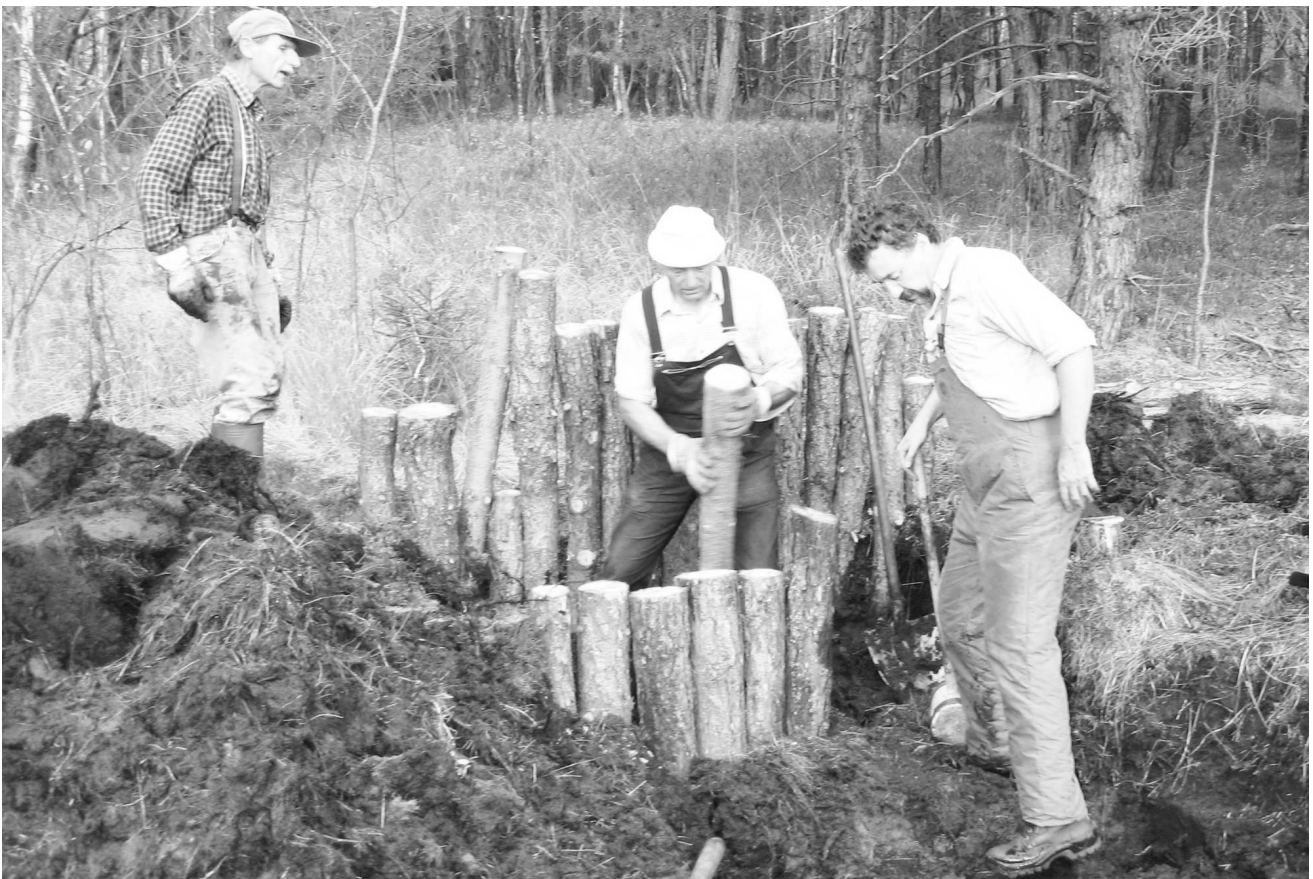
Renaturierung eines Hochmoores im Naturschutzgebiet Magnetsrieder Hardt. Durch den Querdamm kann das Wasser nicht mehr abfließen und bleibt im Moor.
