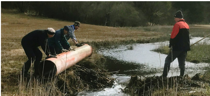
Einbau eines „Biberrohrs“ am Ettinger Bach neben unserem Grundstück. Damit kann der Wasserstand abgesenkt werden und der Biber kommt damit auch klar.
