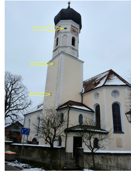
Kirchturm St. Vitus mit geeigneten Öffnungen, hinter denen Dohlenkästen angebracht werden könnten (Pfeile).
