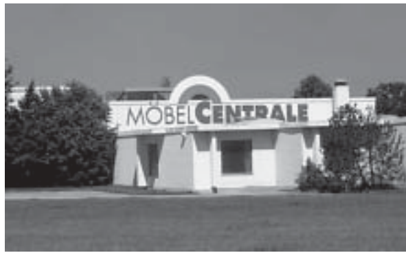
Das bestehende Möbelhaus in Altenstadt
