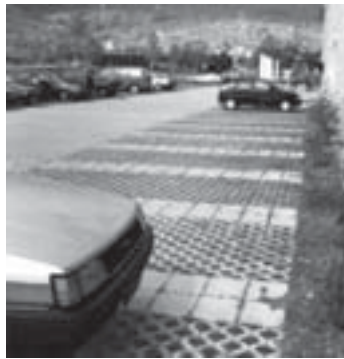
Bei Parkplätzen, Höfen und Zufahrten vermehrt Verwendung von Rasengittersteinen, Rasenpflaster, Schotterrasen usw.
